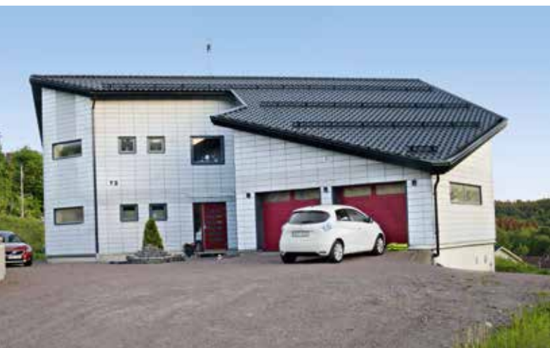
Abb. 1: Seit März 2015 wird das drei Stockwerke hohe Haus vollständig netzunabhängig mit Solarstrom und Wasserstoff versorgt
